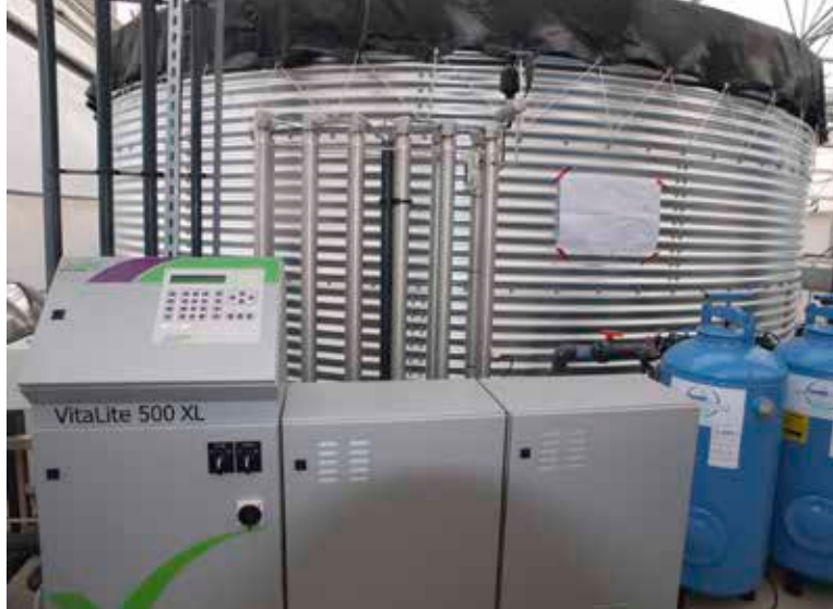
Fot. 13. W ubiegłym roku M. M. Głowaccy zainwestowali też w nowe centrum nawożenia z nawadnianiem (gdzie m.in. znajduje się zestaw do odkażania pożywki promieniami UV)
