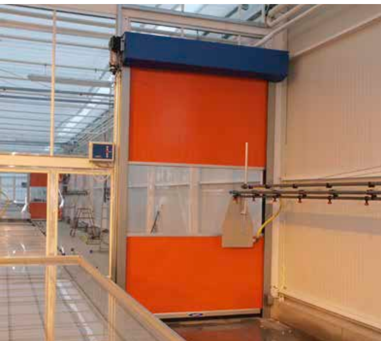
Fot. 8. Pomiędzy poszczególnymi sektorami szklarni – a także pomiędzy szklarnią i halą – zamontowano bramy foliowe
