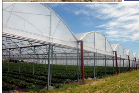
Fot. 9. Postawiony w 2017 roku blok foliowy składa się z 14 naw; zostanie wyposażony w żwirową posadzkę zalewową
