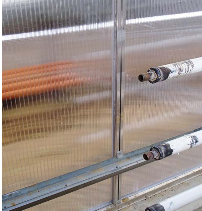
Fot. 11. Boczne ściany tunelu wykonano z płyt poliwęglanowych
