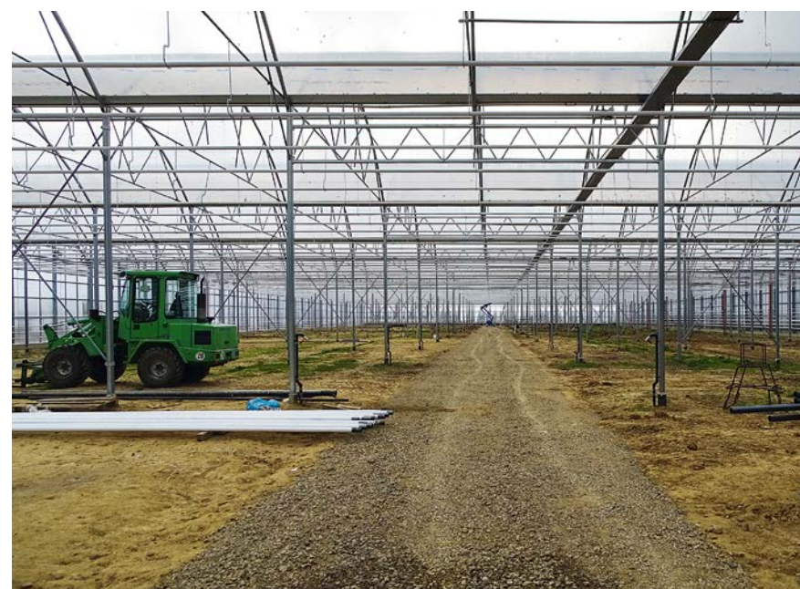
Fot. 9. Postawiony w 2017 roku blok foliowy składa się z 14 naw; zostanie wyposażony w żwirową posadzkę zalewową
