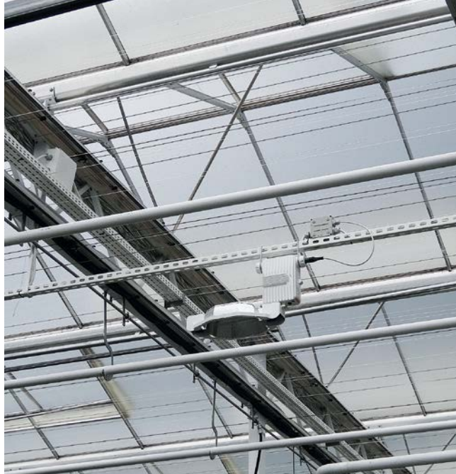
Fot. 7. Obiekt zbudowany w sezonie 2015/2016 pokryty jest szkłem dyfuzyjnym
